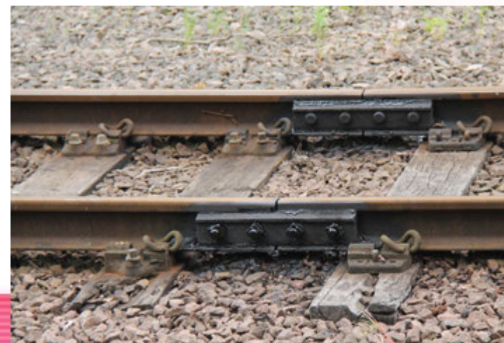
Fig. 2 – rails éclissés
