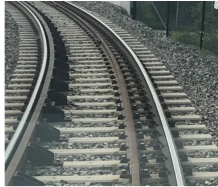
Fig. 1 – rails soudés (en haut)
